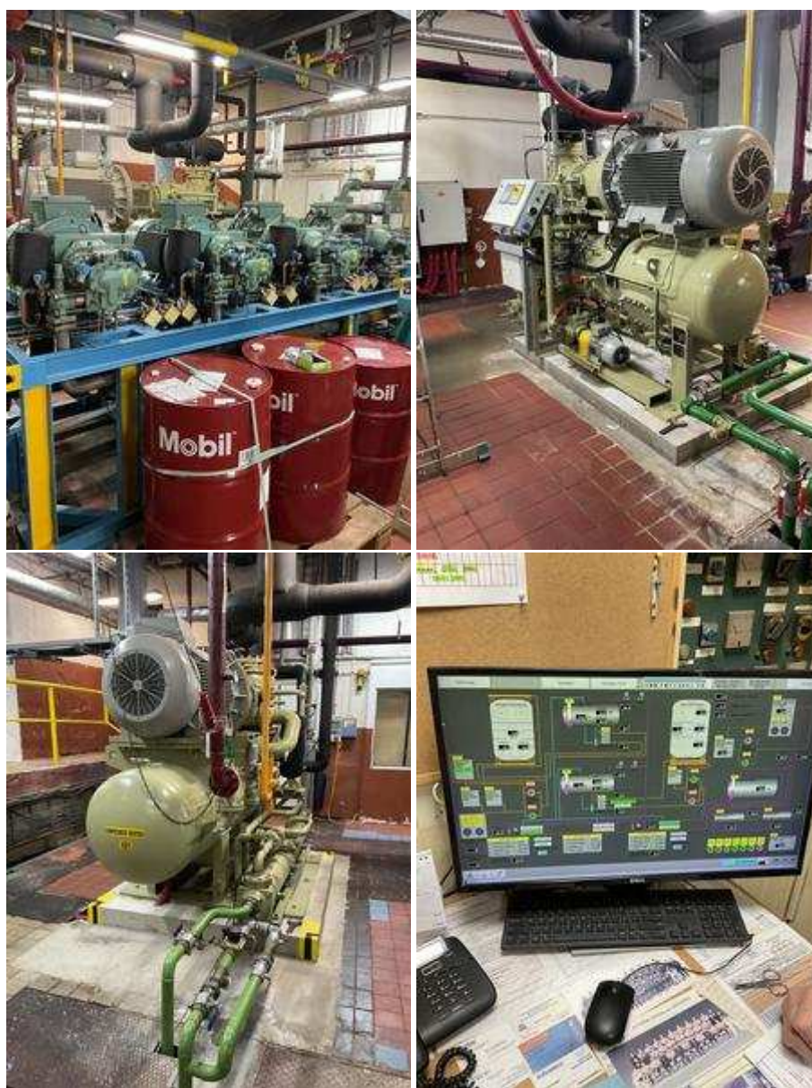
Obrázek 8 - technologie chlazení zimního stadionu
