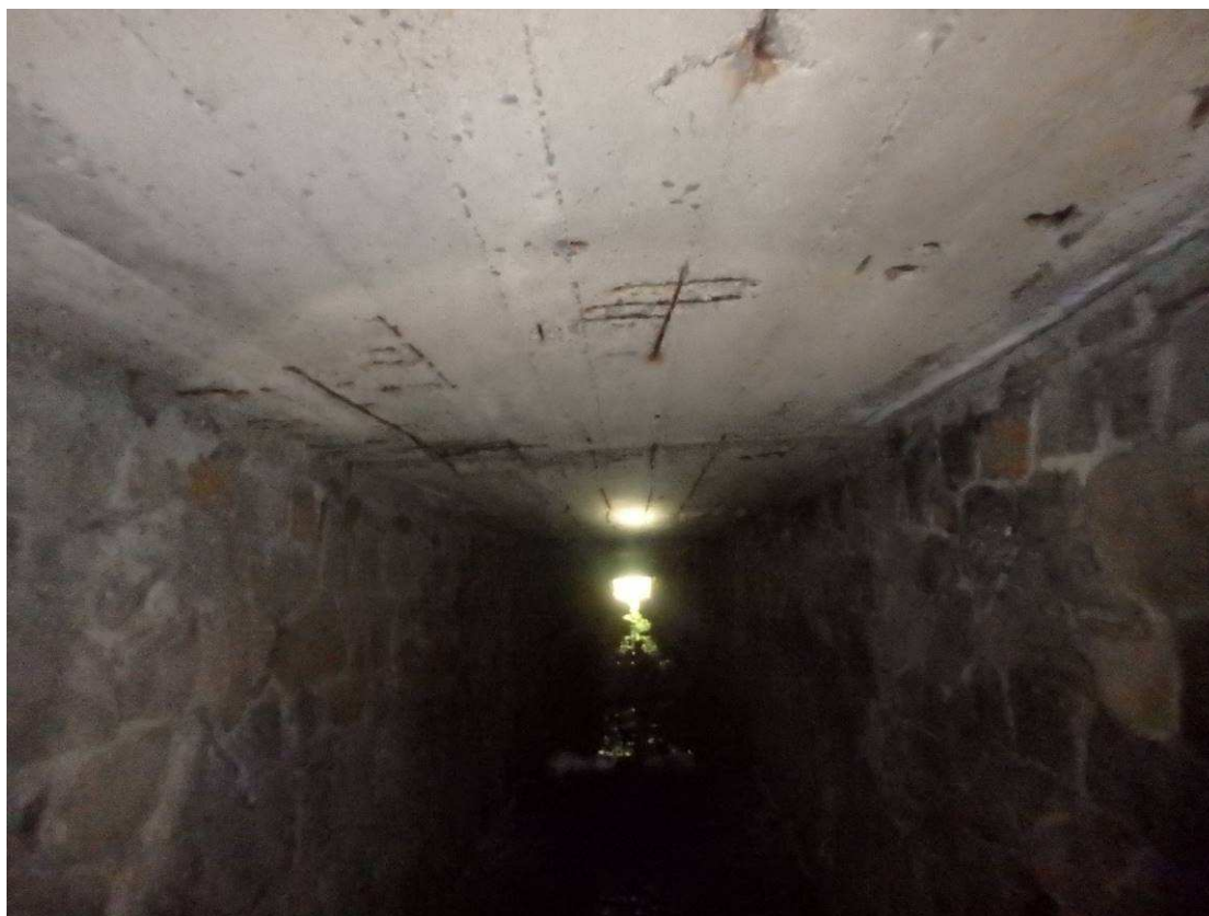
Podhled nosné konstrukce
