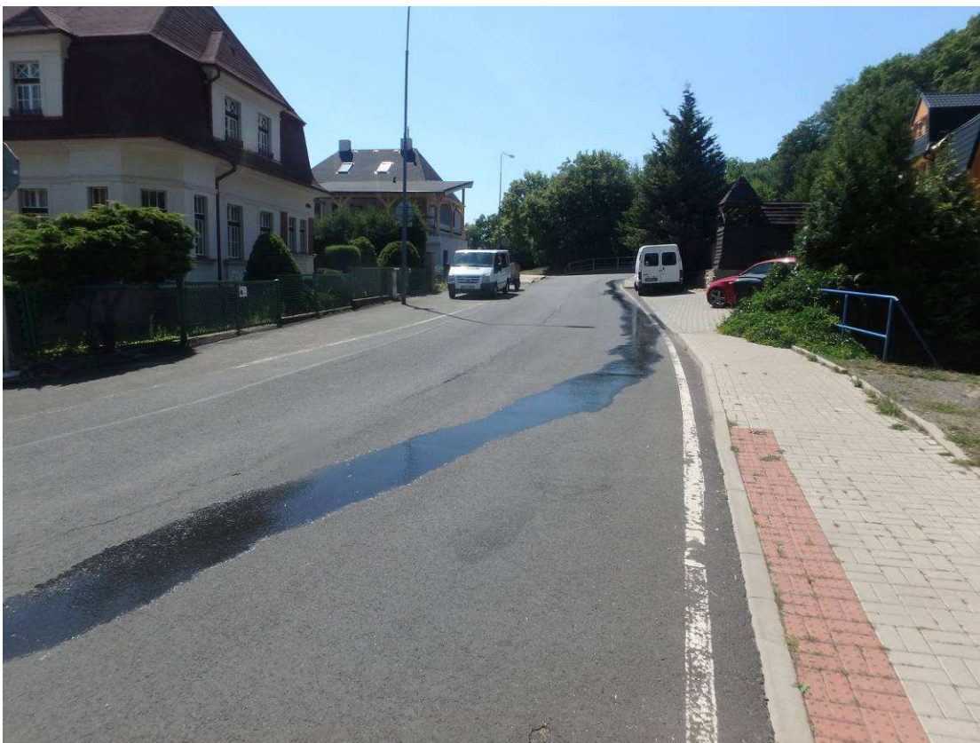
Šířkové uspořádání na mostě - pohled po směru staničení
