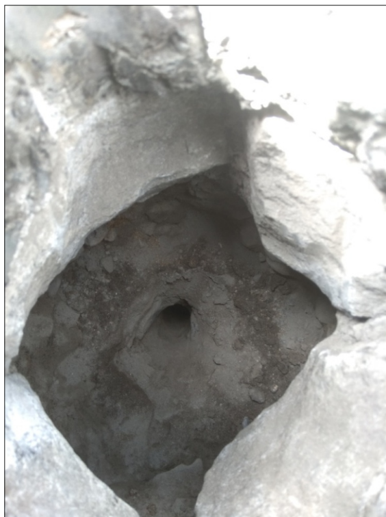
podkladní beton zastiženy sondou S2
