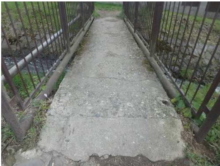
Degradace horního líce lávky.
