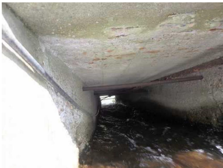
Podhled nosné konstrukce.
