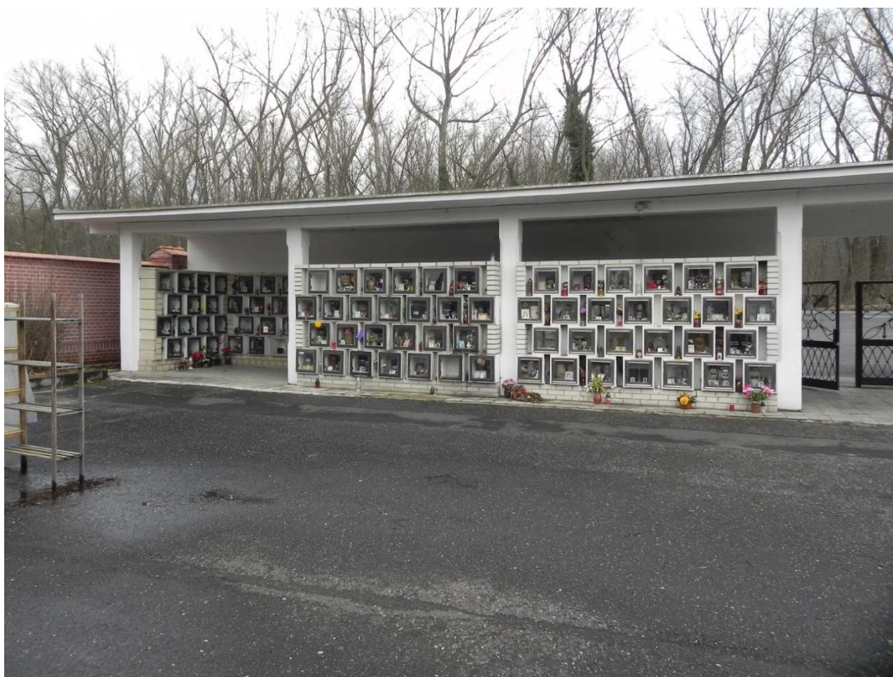
Obr. 9 – Stávající kolumbária po pravé straně při vstupu, pohled jižní
