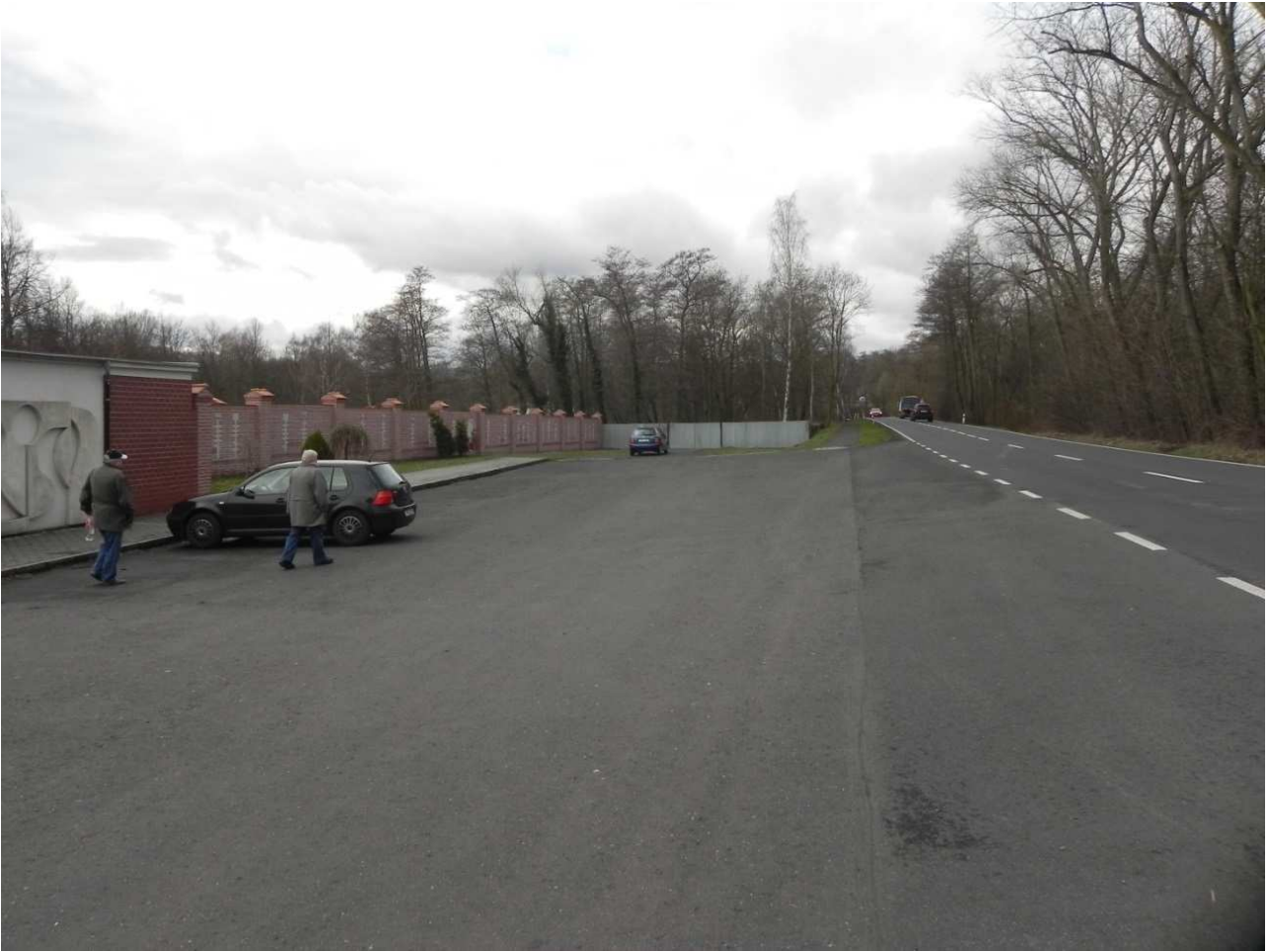
Obr. 3 – Venkovní parkoviště; řešení vyznačených parkovacích míst a vjezdu/výjezdu: pohled východní
