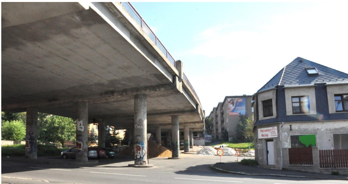
P09 - fotodokumentace území čp. 745 v blízkosti mostu
