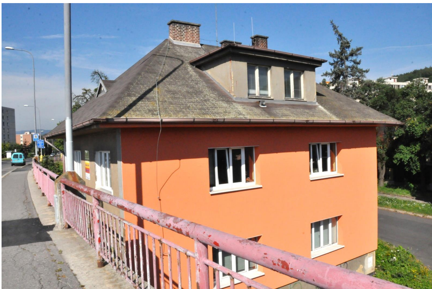
pohled z mostu na čp. 764
