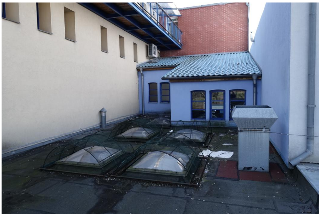
Pohled na střední část stávající střechy a světlíky s ochrannými koši
