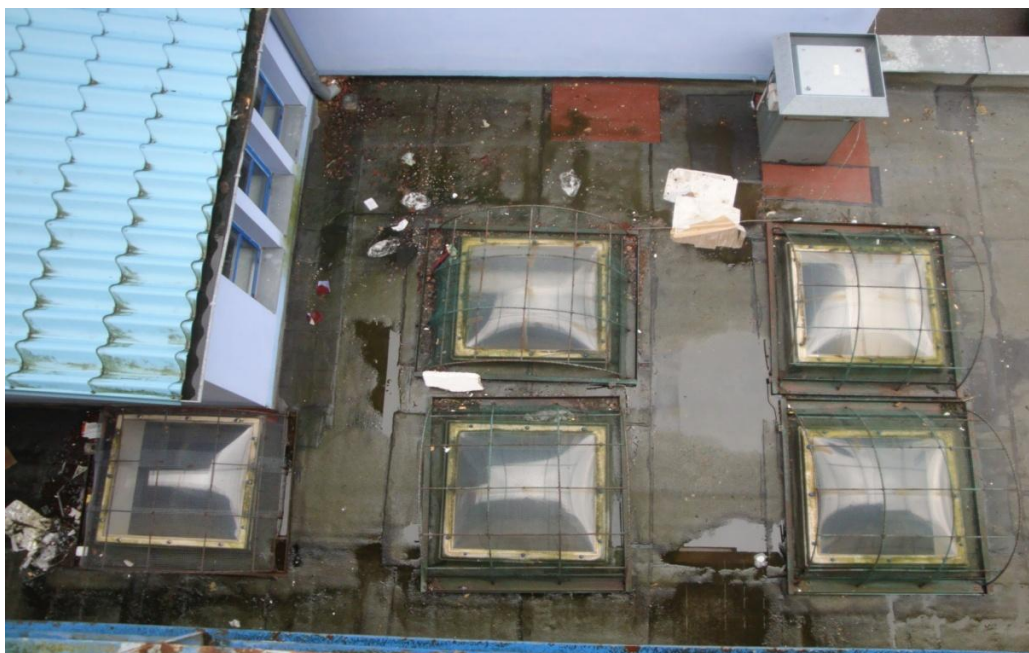
Pohled na střední část stávající střechy a světlíky s ochrannými koši
