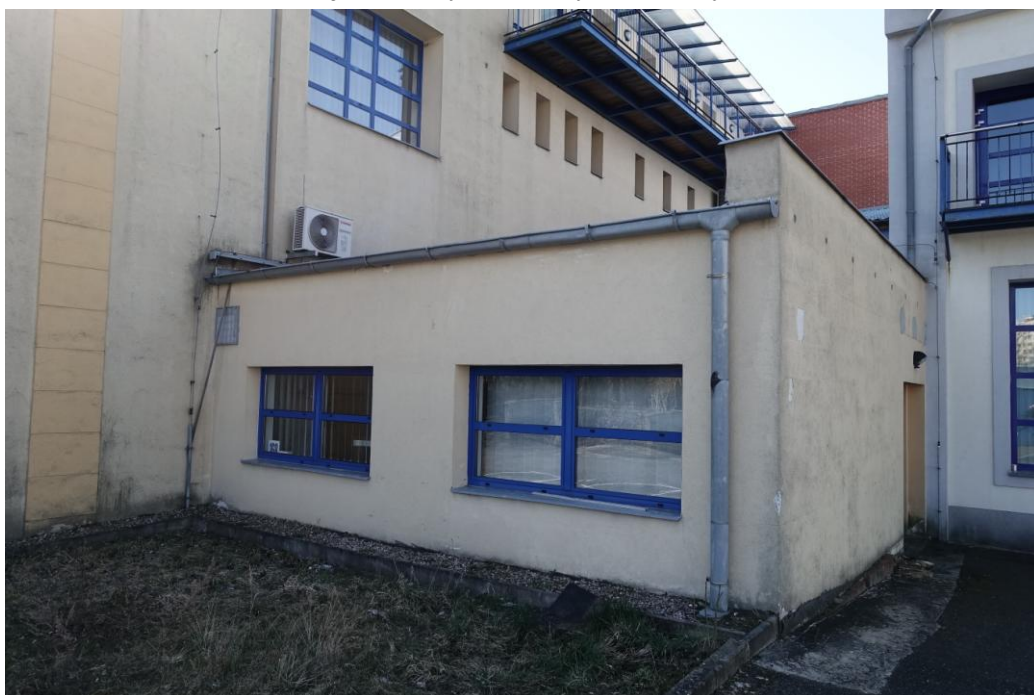
Pohled- ukončení a stávající odvodnění střechy
