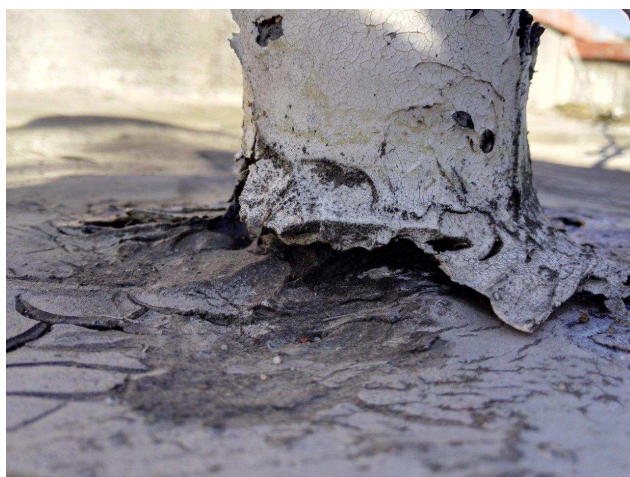
Foto 3 - detail opravy odvětrání.
