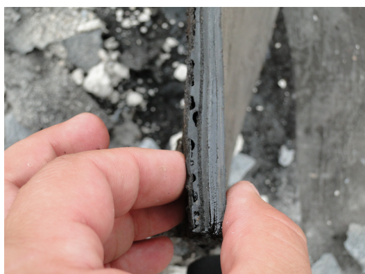
detail hydroizolačního souvrství
