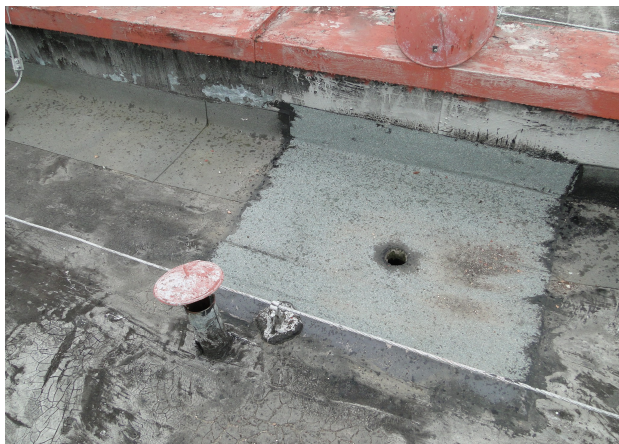
detail střešní vpusti středové části střechy
