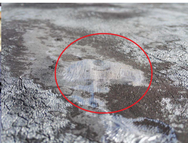
Foto 4 – detail obnažené nosné vložky.
