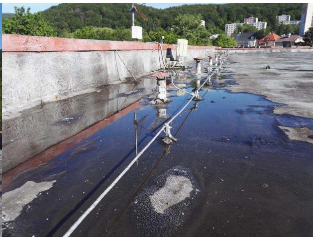
Foto 2 – pohled na neodvodněnou oblast v blízkosti atiky.
