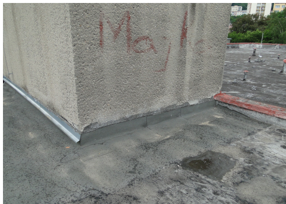
detail oplechování a chybného oplechování
