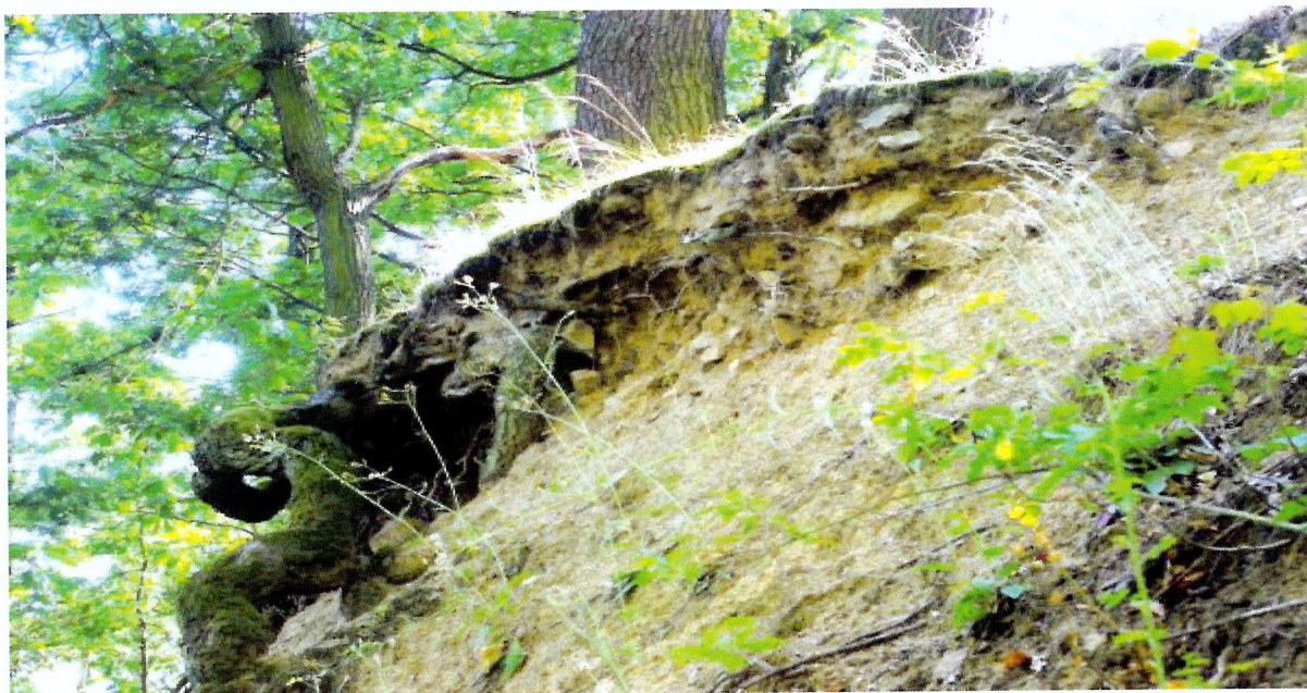
Obr. 7 Pohled na kvartérní pokryv (hlinito-kamenitá suť) v nadloží skalního podkladu. Ze snímku je patrné i negativní působení kořenových systémů stromů situovaných na hraně svahu.
