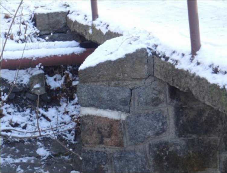
Rozpad zdiva pilíře.
