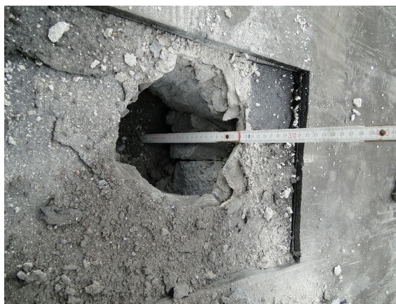
detail sondy střešního pláště
