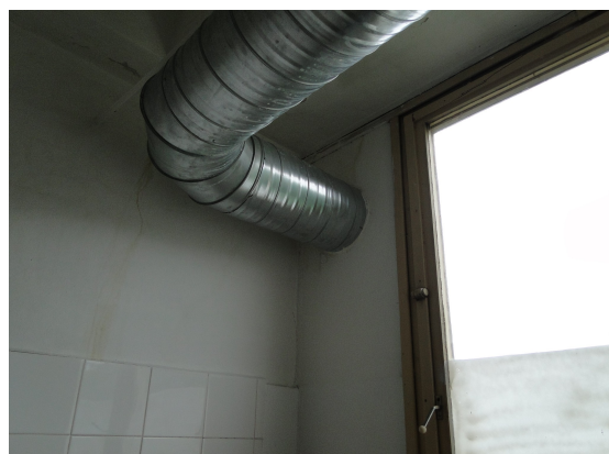
procházející vzt. potrubí meziokenní vložkou
