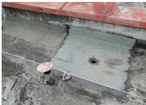
detail střešní vpusti středové části střechy
