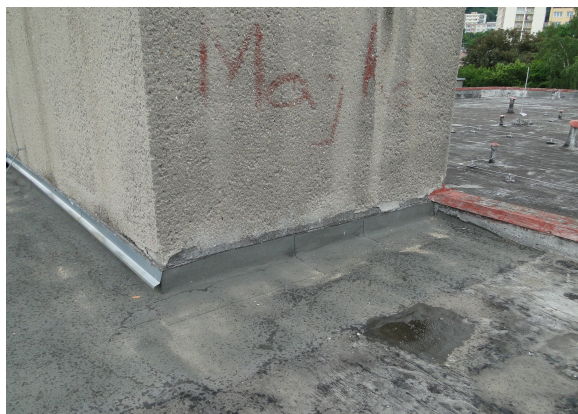
detail oplechování a chybějícího oplechování
