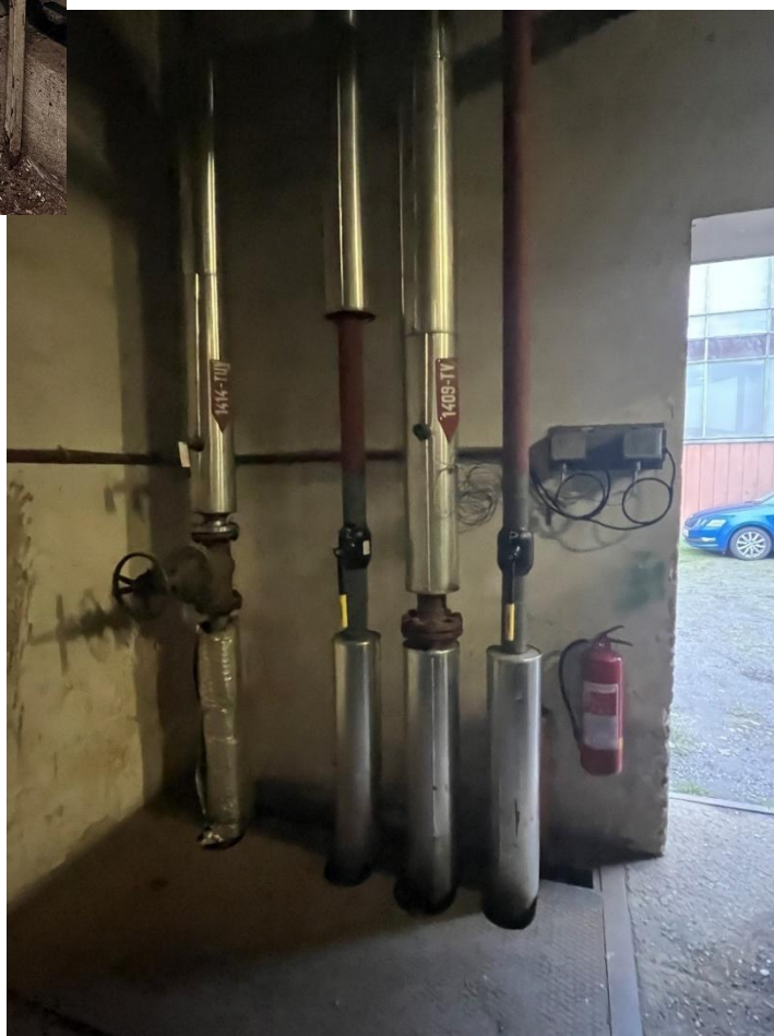
Horkovodní přípojka u vstupu a propojení s plaveckou halou
