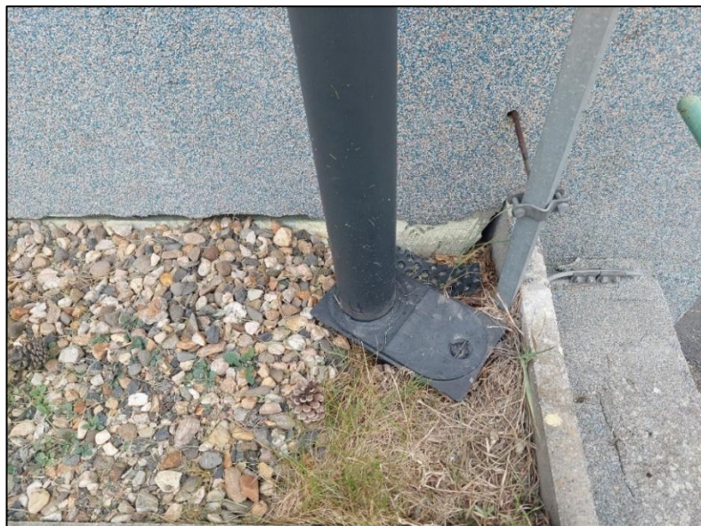
Detail venkovních svodů, špatně ukončená nopová fólie
