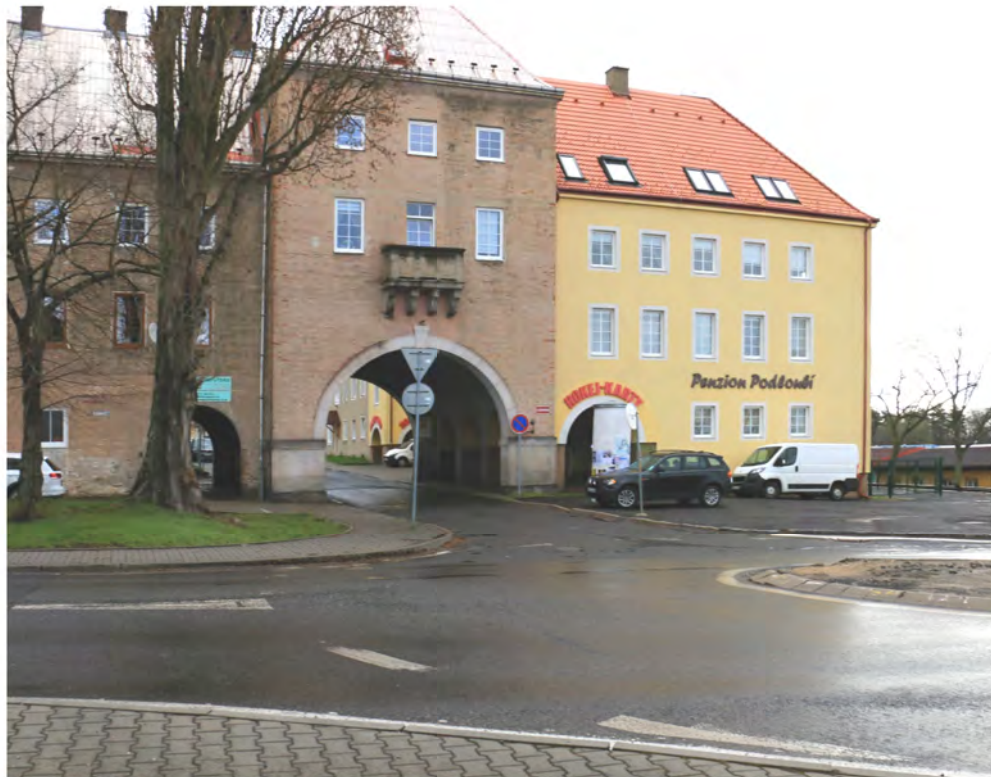
Pohled na průjezd a průchody v ulici Vrchlického
