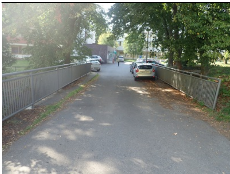
Pohled po směru staničení
