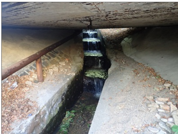
Podhled nosné konstrukce
