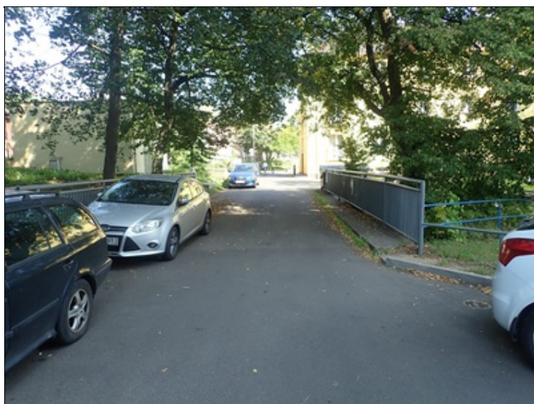
Pohled proti směru staničení
