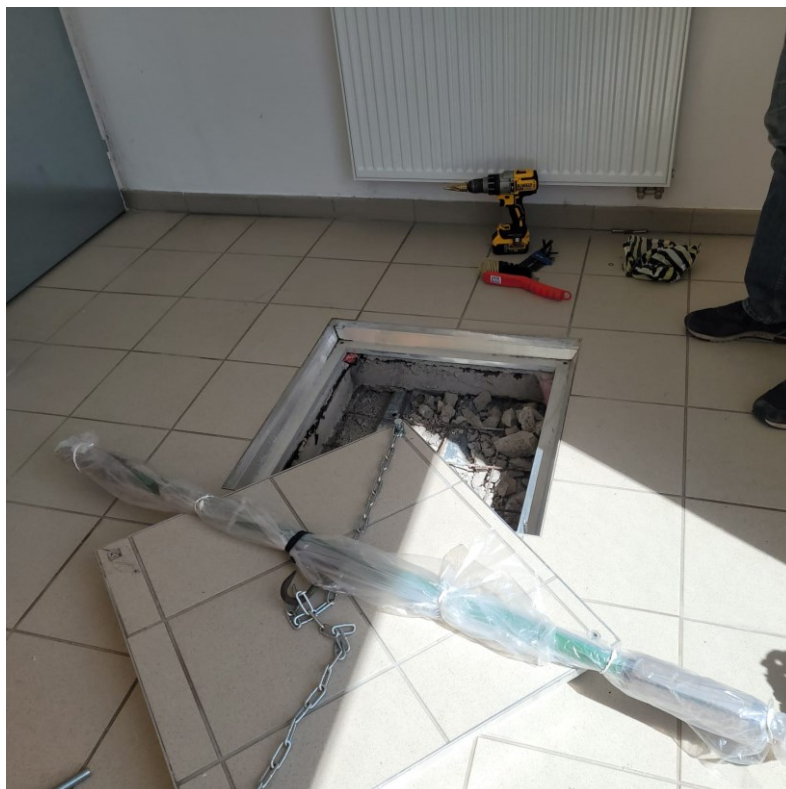
Topný kanál po rekonstrukci – spojovací chodba
