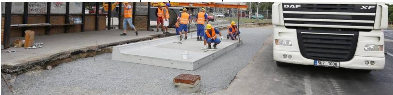
Pokládka zastávkového betonového panelu (ilustrační foto)
