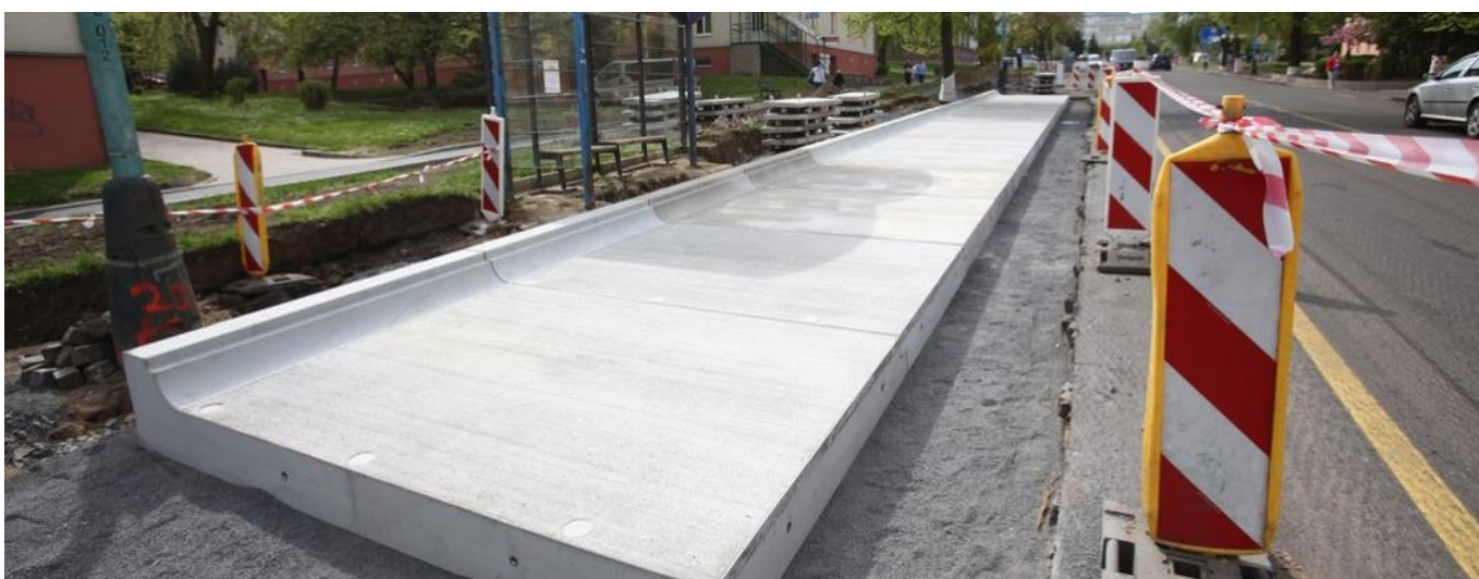
Založení betonového panelu do zastávkového zálivu (ilustrační foto)
