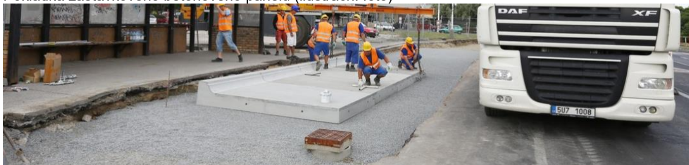
Pokládka zastávkového betonového panelu (ilustrační foto)
