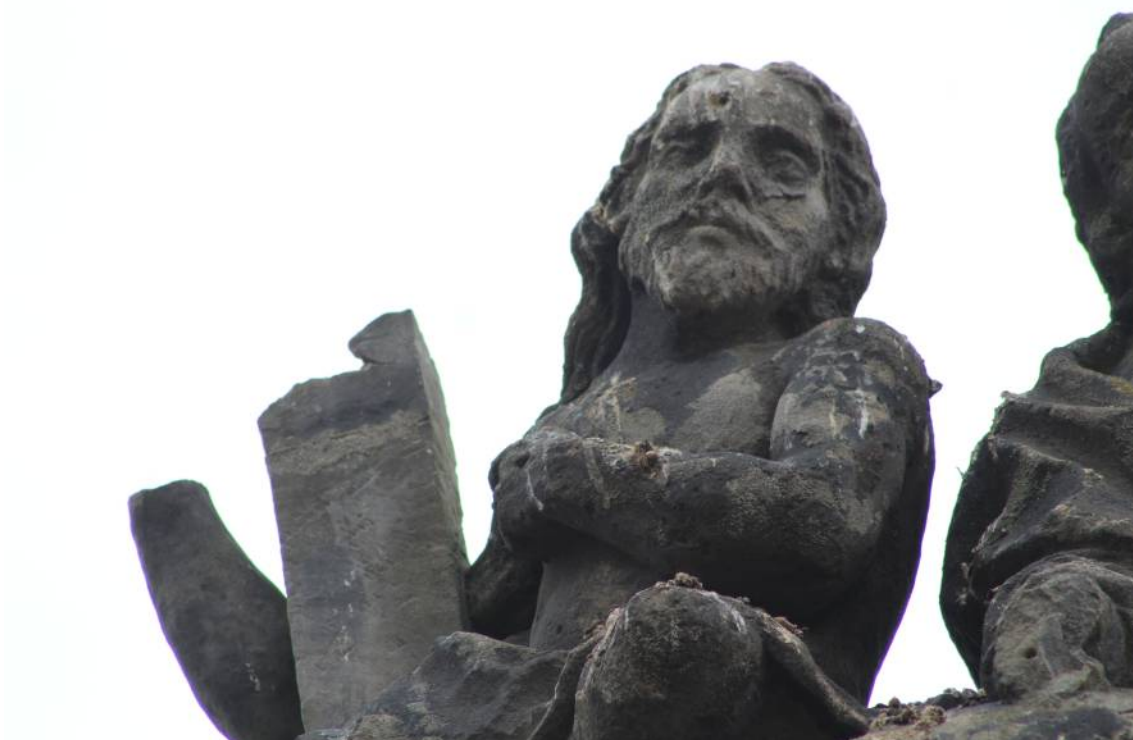
Pohled na zadní a přední stranu figury Krista s chybějící pravou rukou. Silné povrchové znečištění a postupující degradace kamene pod neprodyšnou krustou.
