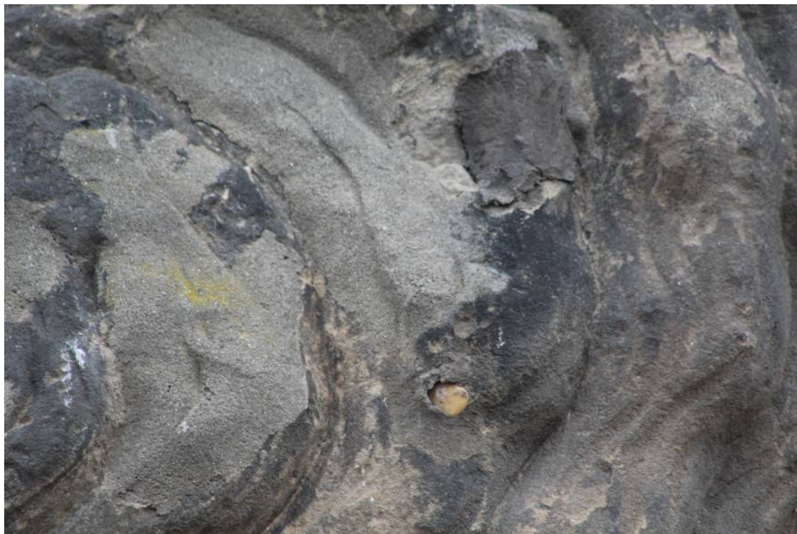
Spodní pohled na figuru Boha Otce. Detail modelace oblaku - novodobé cementové překryvy, doplňky a degradace kamene pod černou neprodyšnou krustou.
