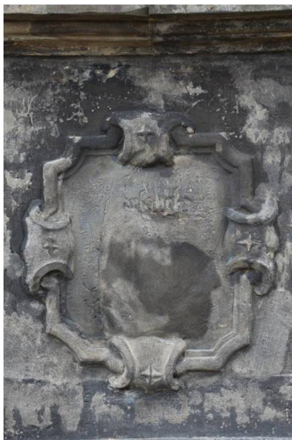
Kartuše na podstavci - četná mechanická poškození, vrstvy krusty.
