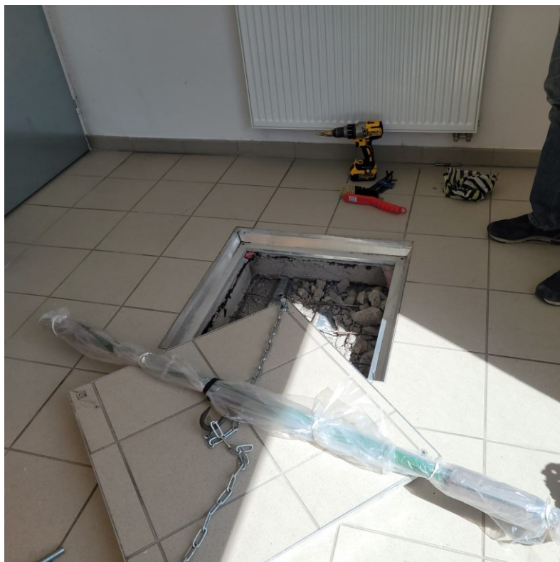
Topný kanál po rekonstrukci – spojovací chodba
