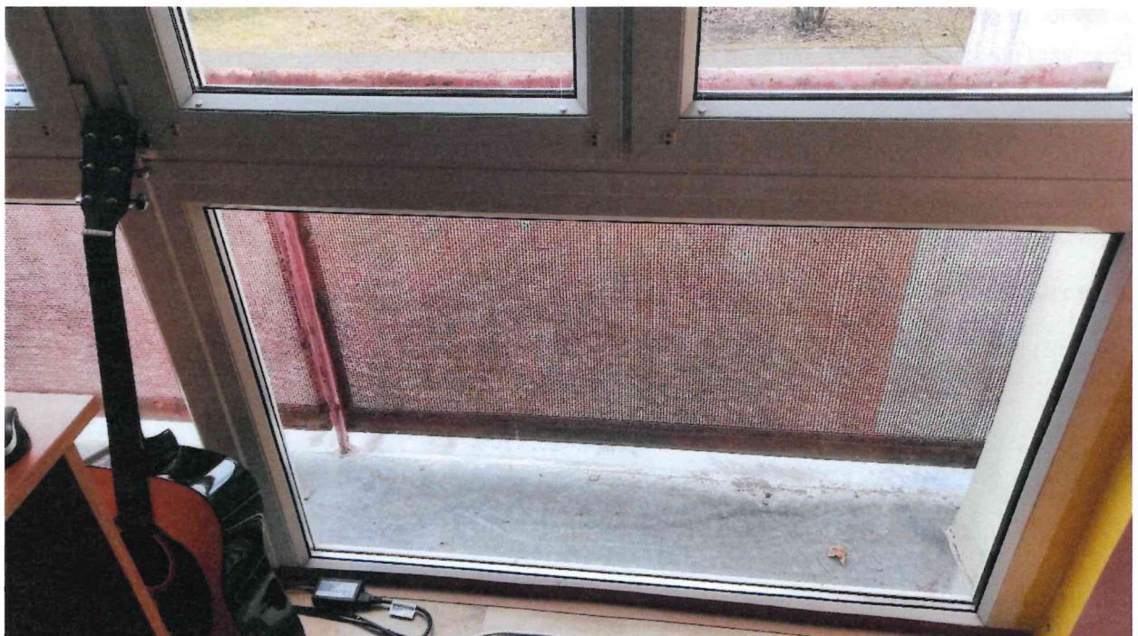
Zábradlí u balkonků
