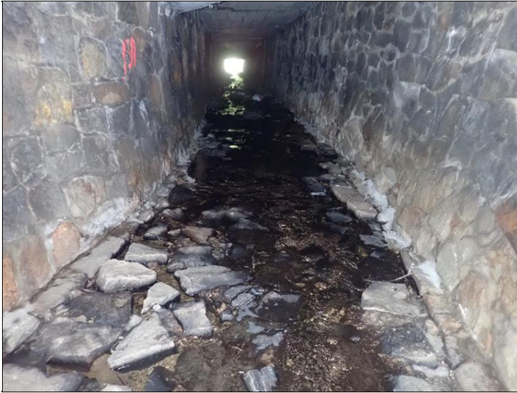
Podhled nosné konstrukce
