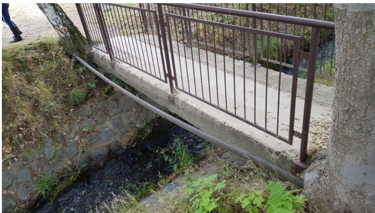
Obr.4-Pohled na lávku směrem ulice K Loučkám, 1x stávající chránička IS na výtokové straně vedle mostovky
