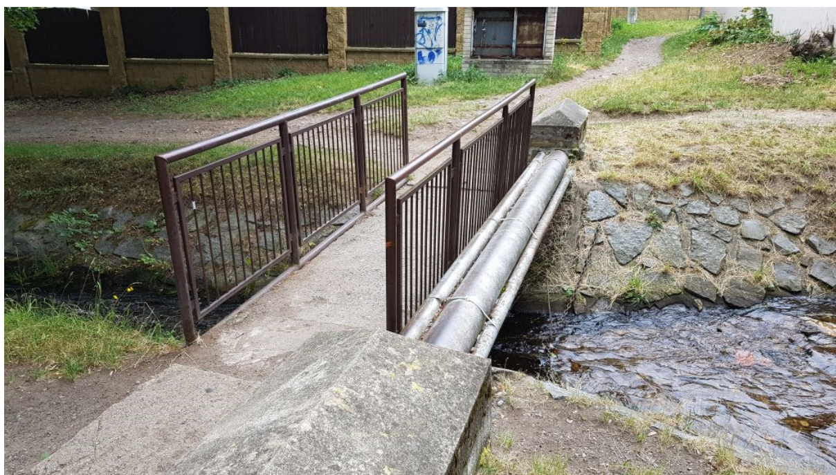
Obr.4-Pohled na lávku směrem ulice K Loučkám, 3x stávající chránička IS na nátokové straně vedle mostovky
