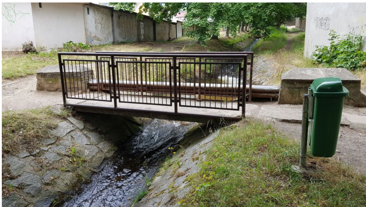
Obr.5-Pohled na lávku z výtokové strany – nosná konstrukce, spodní stavba, 3x stávající chránička IS na nátokové straně vedle mostovky
