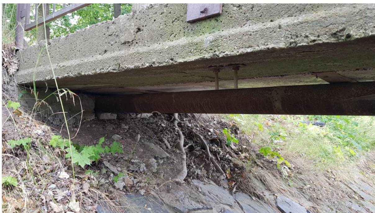
Obr.8- Pohled na lávku z nátokové strany – pravobřežní opěra, 1x stávající chránička IS pod mostovkou
