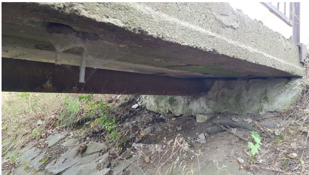
Obr.7-Pohled na lávku z nátokové strany – pravobřežní opěra, 1x stávající chránička IS pod mostovkou
