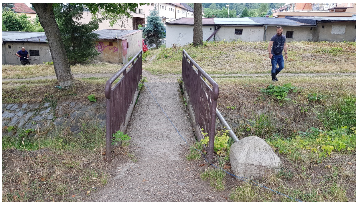
Obr.4-Pohled na lávku směrem ulice K Loučkám, 1x stávající chránička IS na nátokové straně vedle mostovky
