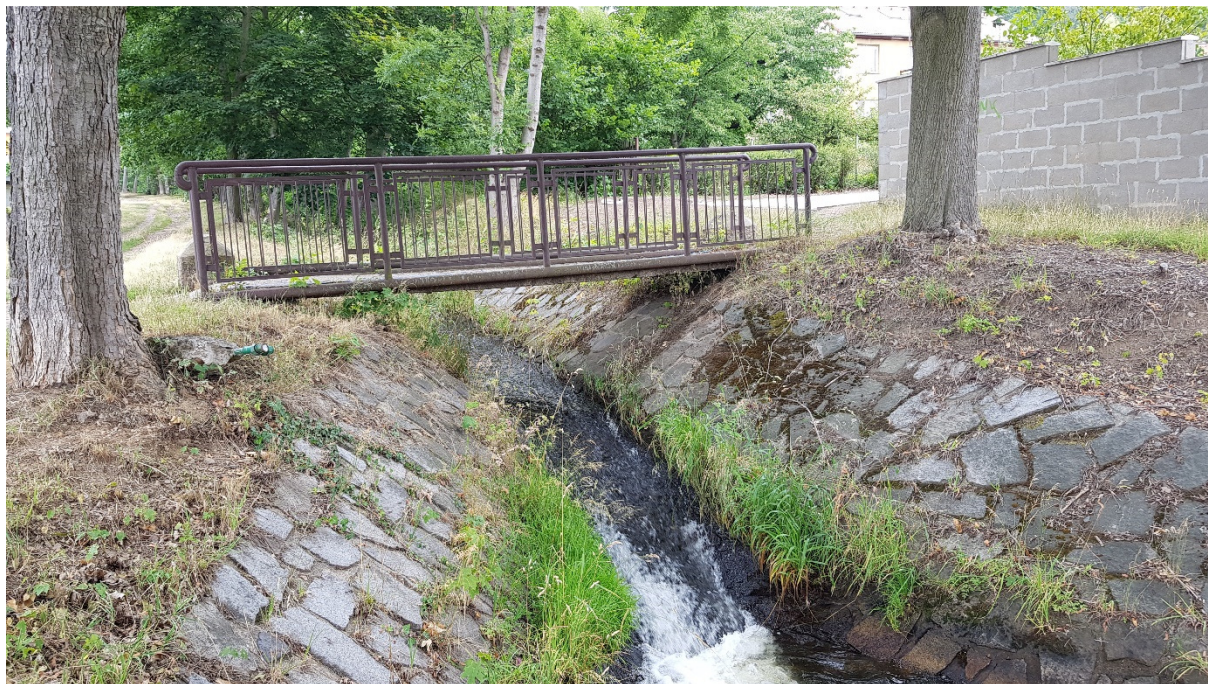
Obr.5-Pohled na lávku z výtokové strany – nosná konstrukce, spodní stavba, 1x stávající chránička IS na nátokové straně vedle mostovky
