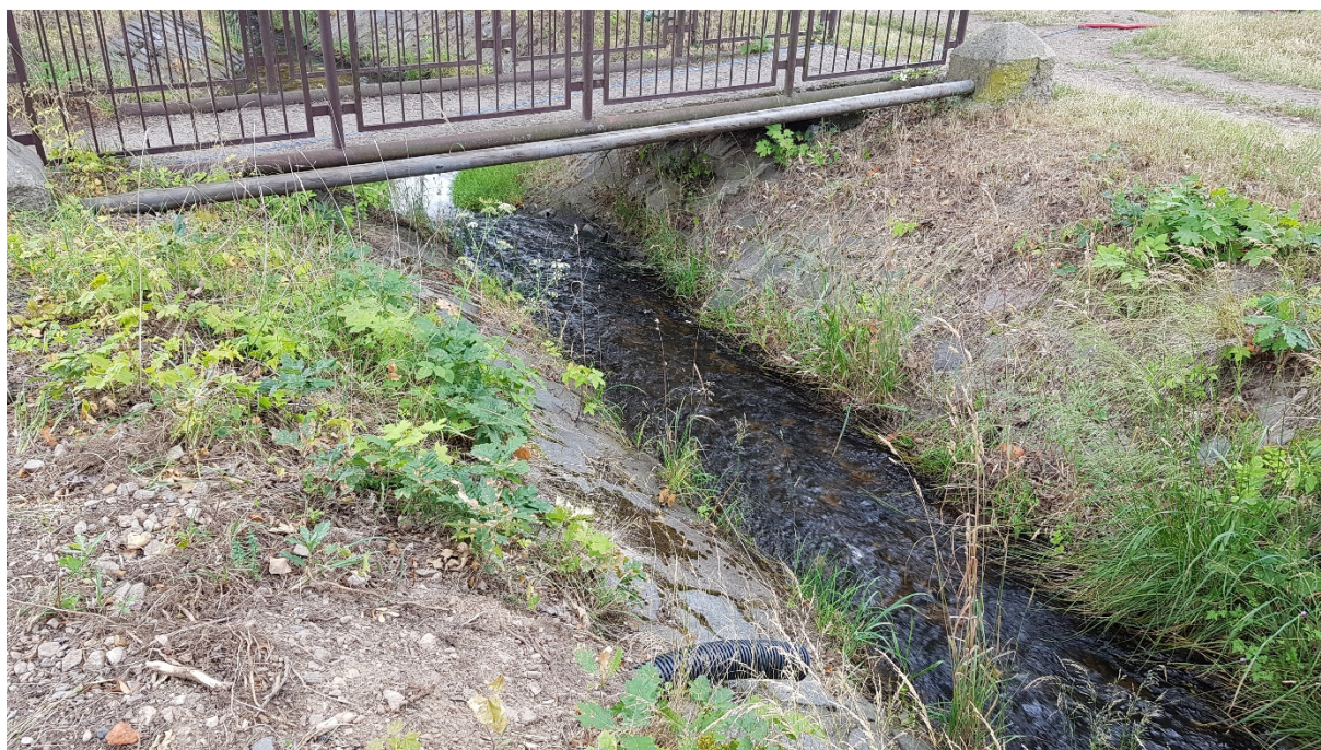
Obr.6-Pohled na lávku z výtokové strany – 1x stávající chránička IS vedle mostovky
