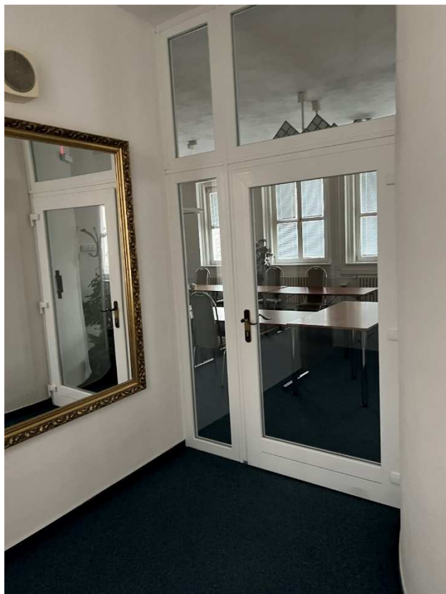
Vstup do zasedací místnosti 2, který bude nahrazen novou hliníkovou sestavou dveří
