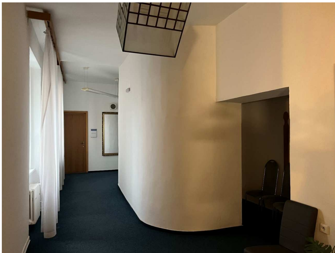
Vpravo vstup do mezipatra (na balkon) z chodby, vč. zděné zaoblené stěny k odstranění
