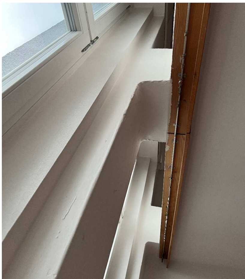
Pohled na okna zdola (ze spojovací části) nahoru, detail napojení podlahy mezipatra
