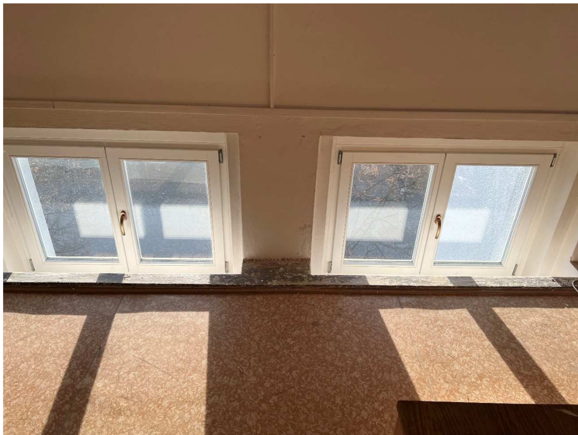
Pohled na horní části oken z mezipatra (balkonu)
