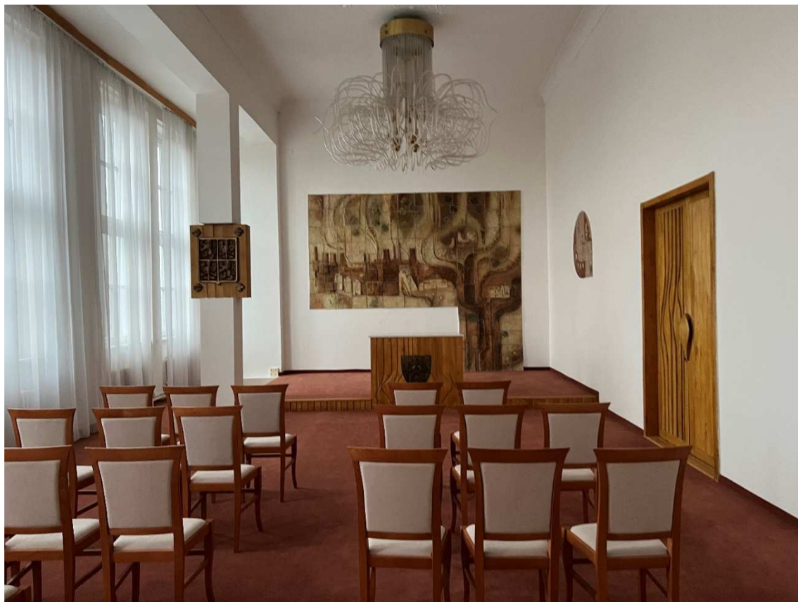
Pohled od spojovací části na pódium, vzadu pódium a velká mozaika (bude překryta předstěnou z SDK desek), vpravo dřevěné vstupní dveře, které budou ponechány
