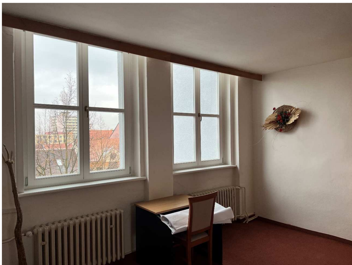
Spojovací část je výškově předělena podlahou mezipatra, okna zasahují do obou částí
