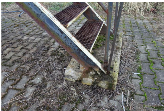
Oprava nosných profilů U140 u kotvení ( vyvaření , vyztužení)
