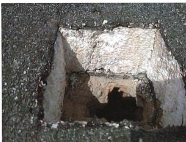
Foto 12 – pohled na sondu S7 střechy pavilonu D.
