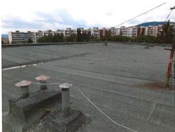
Foto 13 – pohled na střechu pavilonu E.
