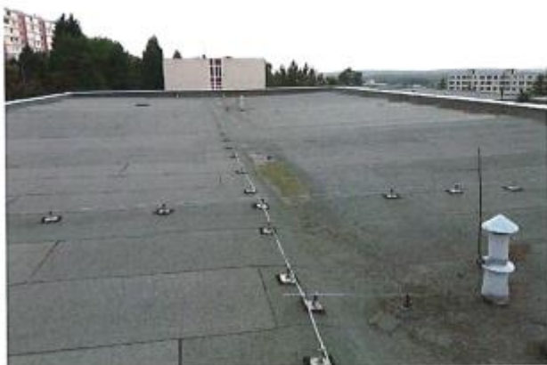
Foto 7 – pohled na střechu pavilonu B.
