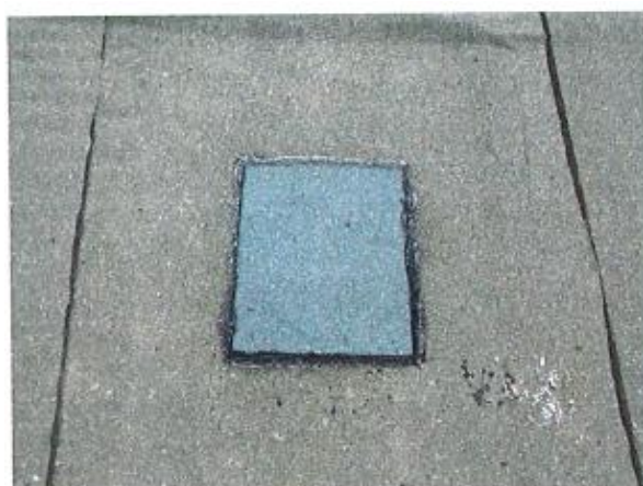
Foto 17 – pohled na zapravenou sondu S13 střechy A
