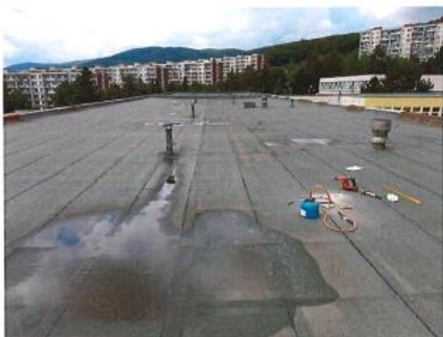
Foto 11 – pohled na střechu pavilonu D.
