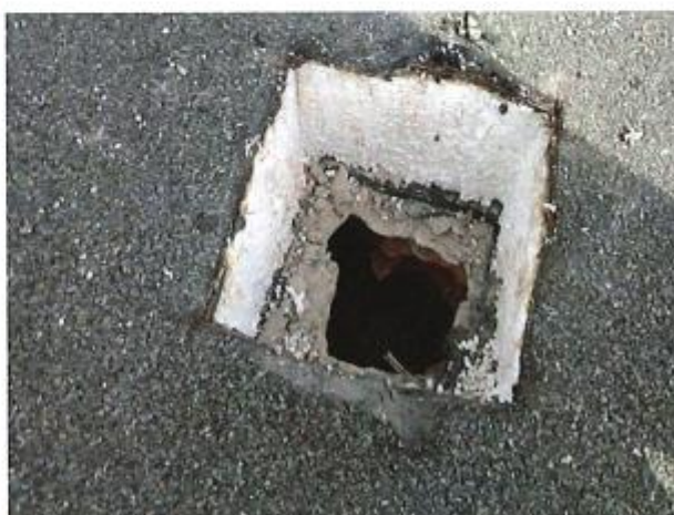
Foto 4 – pohled na sondu S15 střechy pavilonu A1.
