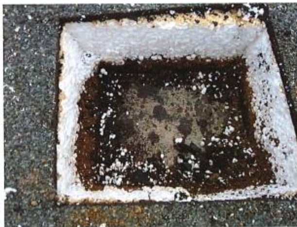
Foto 8 – pohled na sondu S11 střechy pavilonu B.
