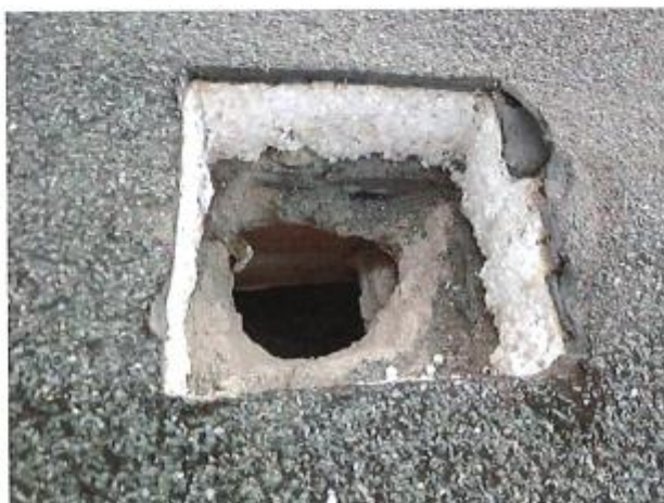
Foto 14 – pohled na sondu S9 střechy pavilonu E.
