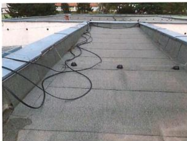
Foto 5 – pohled na střechu pavilonu A2.
