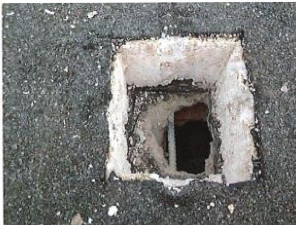
Foto 6 – pohled na sondu S8 střechy pavilonu A2.
