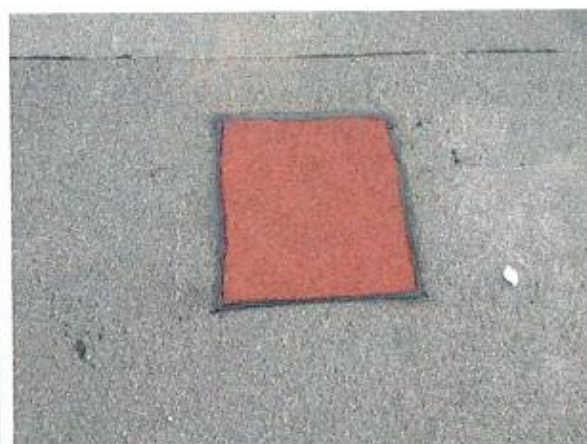
Foto 18 – pohled na zapravenou sondu S11 střechy B
