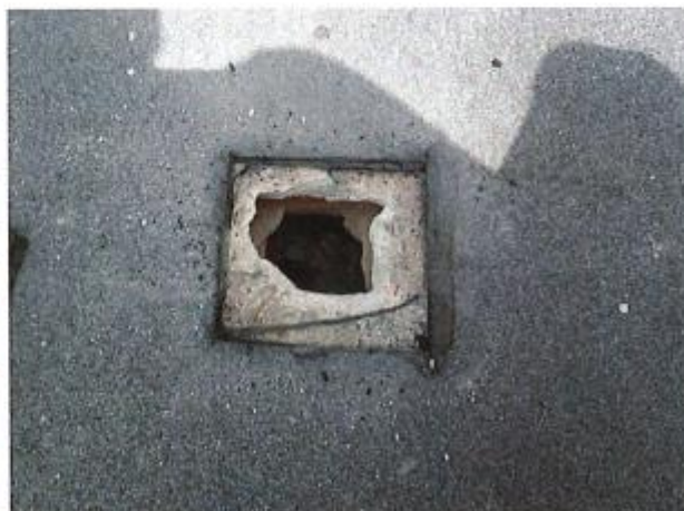
Foto 2 – pohled na sondu S13 střechy pavilonu A.
