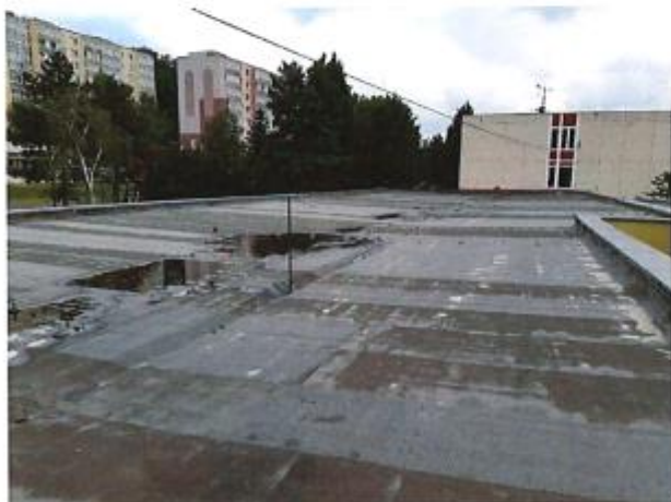
Foto 1 – pohled na střechu pavilonu A.
