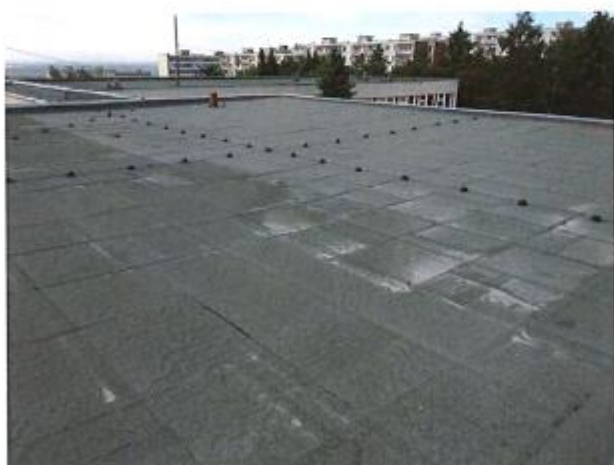
Foto 3 – pohled na střechu pavilonu A1.
